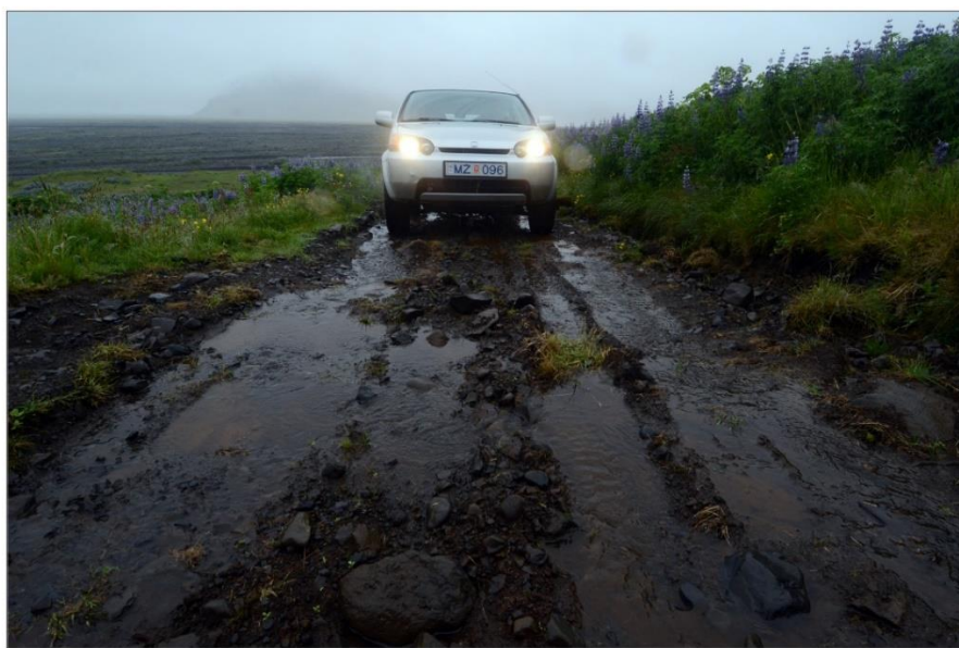
Gilbraut. Staðan er slæm neðan til. Gróft efni, mól og mold. Lækur rennur eftir veginum í vætutið. Getur ekki með góðu móti talist fólksbílafær. Þetta er í talsverðum bratta.
